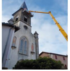
l'assaut du clocher situé à plus de 30 m de hauteur, a permis l'installation de pics et grillage en haut du clocher et à plusieurs étages sur la façade.
